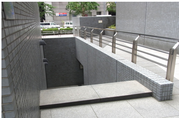
C出入口（外側）
