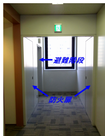
西側・避難階段前の「防火扉」
